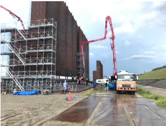
コンクリート打設（ポンプ車打設）
