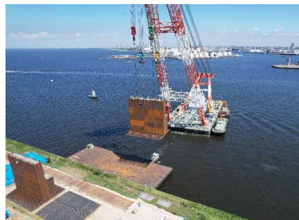
鋼殻海上輸送・水切り 令和4年7月
