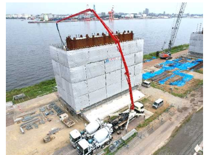
ハイブリッドケーソン製作 令和4年9月
