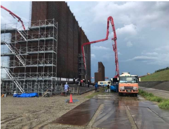
コンクリート打設（ポンプ車打設）
