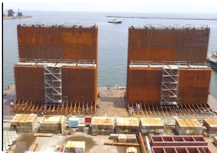
鋼殻完成・工場出荷 令和3年7月
