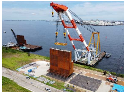
鋼殻海上輸送・水切り 令和3年8月
