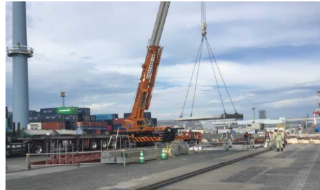
既設栈橋部 渡版(PC桁)切断状況、渡版撤去状況 (令和3年9月)
