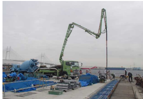
上部工鉄筋組立・コンクリート打設状況 (令和3年8月)
