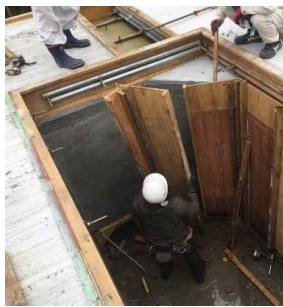
給電ピット型枠解体、炭素繊維複合ケーブル設置状況 (令和3年10月)
