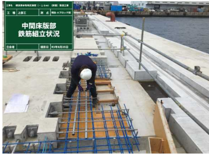
上部工鉄筋組立・コンクリート打設状況 (令和3年8月)
