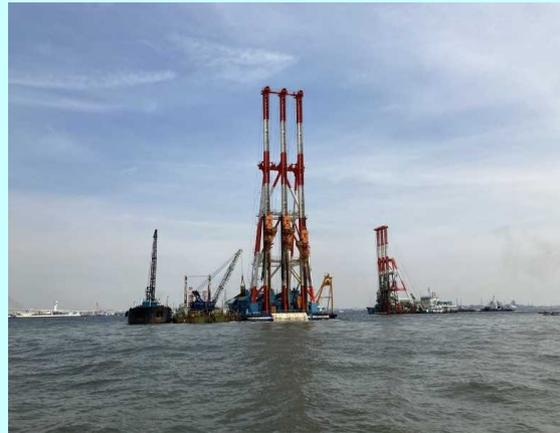
締固工(サンドコンパクションパイル)施工の様子(令和3年5月)
