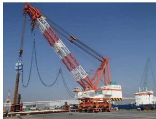
鋼杭工 令和2年11月
