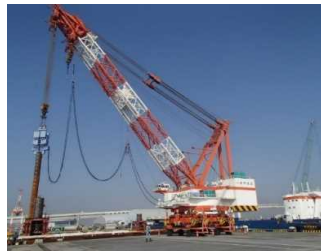
鋼杭工 令和2年11月
