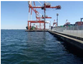
工事着手時 令和2年3月
