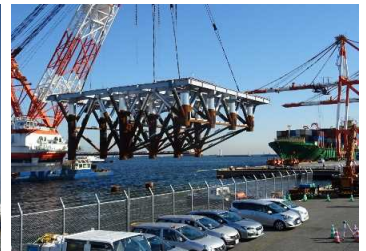
ジャケッ工 令和2年12月
