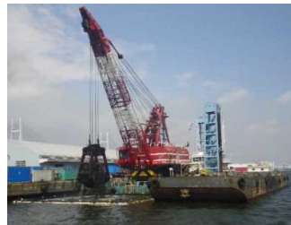
床掘工 令和2年9月
