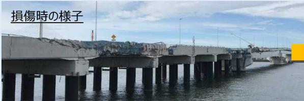
船舶が衝突した部分は損傷が激しく、道路面も大きく歪み、通行が不可能な状態になっていました。
