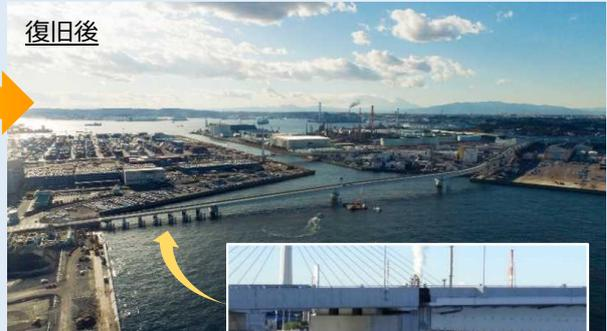
ジャケット式防衝施設が、船舶の橋梁への衝突を防ぎます。
