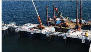
・損傷部分を取り除き、歯抜けになった部分にパーツを設置
