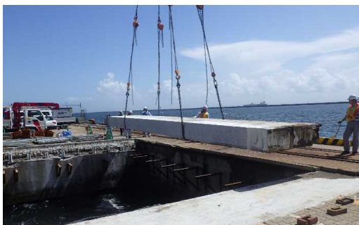
PCホロー桁撤去〔令和2年9月〕
