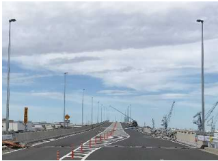
・ 損傷時（令和元年9月）
