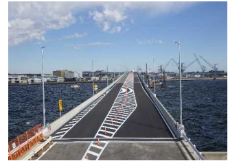
・ 復旧後（令和2年5月）
