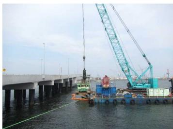
鋼管杭打設のための先行掘削状況
