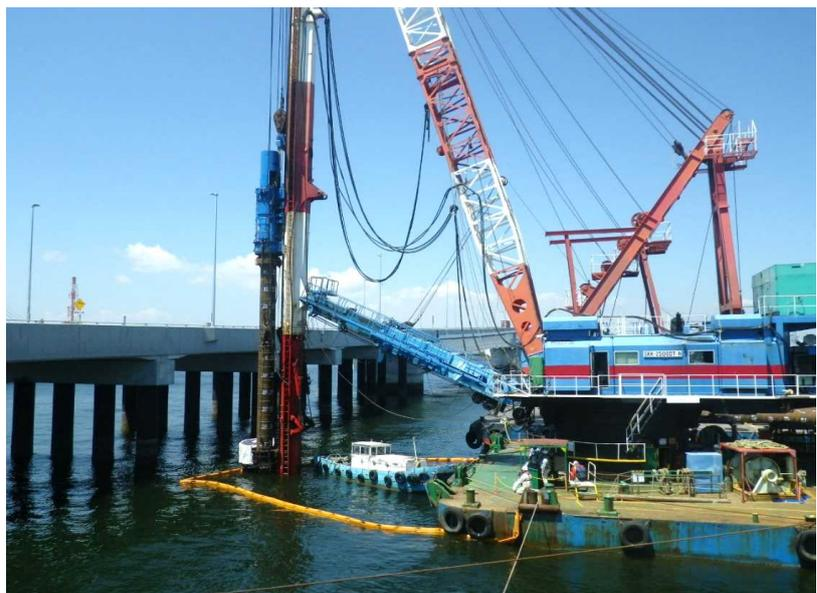
ジャケット式防衛工の鋼管杭打設状況
