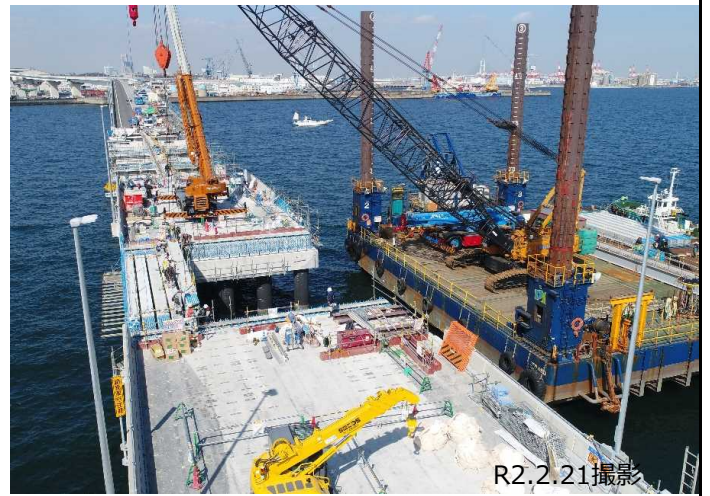
新しく製作した橋桁の設置状況
