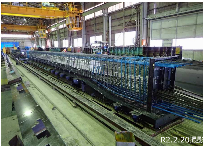
新しく設置する橋桁の製作状況
