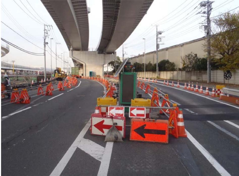
写真② (断面 B) 高架下に側溝を整備して、車道をきれいにします。
