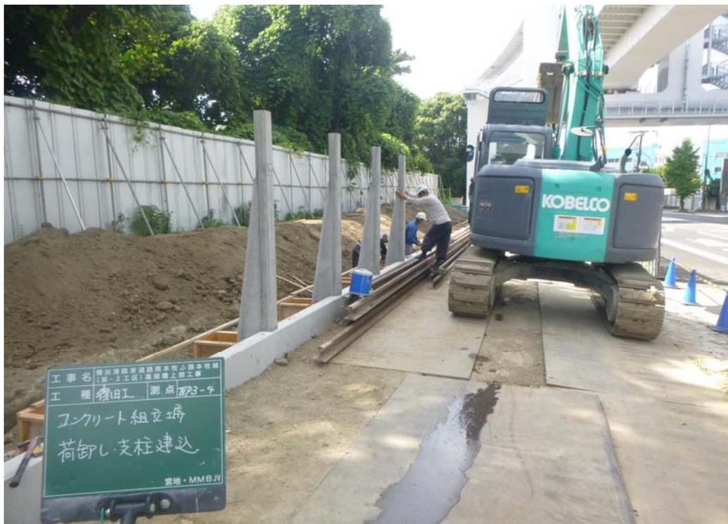
橋梁架設工事で使用していたヤードにて、用地境界にコンクリート製の塀を設置する作業を行っています。
