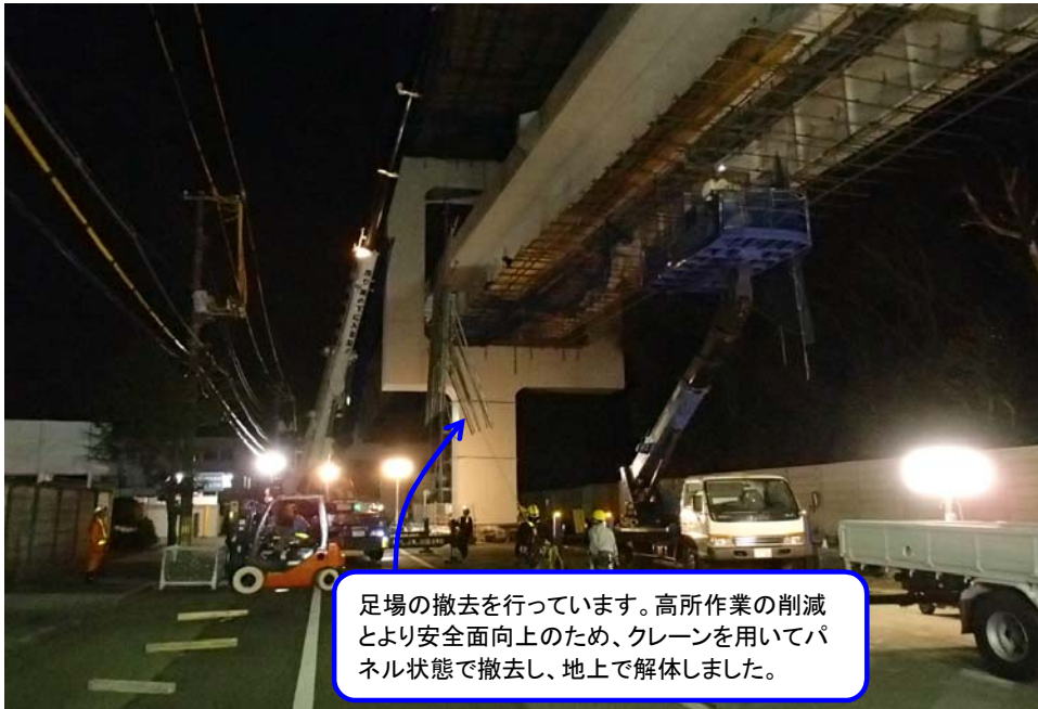
写真① 夜間足場解体状況(下り線)
