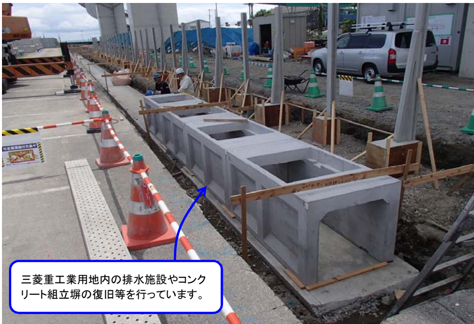
写真② 組立塀・可変側溝設置状況
