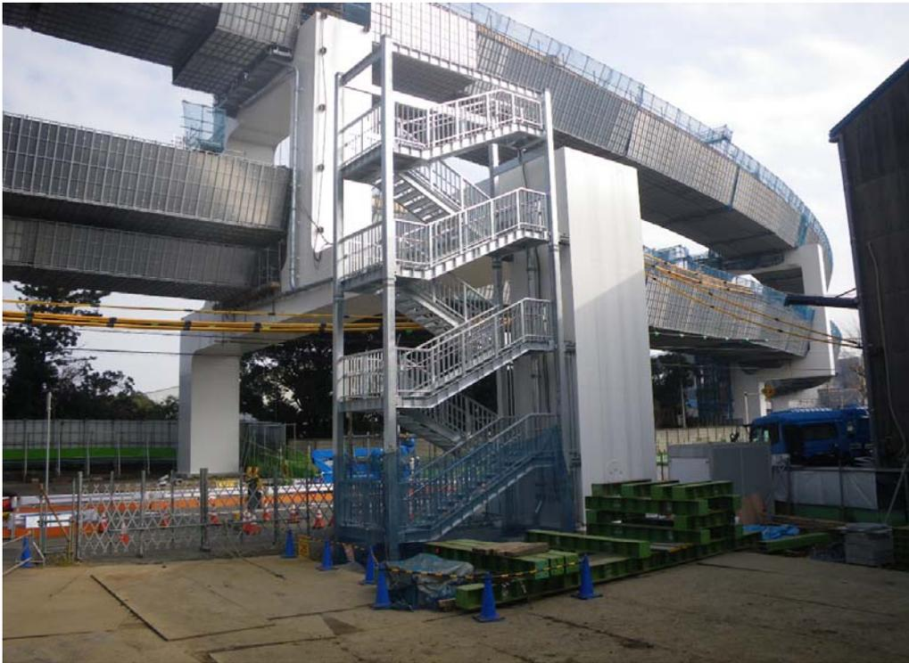
緊急時に橋桁上から地上に移動するための階段の設置作業をしています。市道52号線上に設置する階段については、夜間作業にて設置をします。
