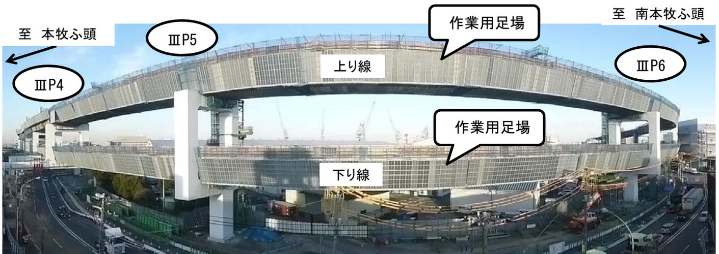
日中は、作業用足場の中で壁高欄コンクリートの打設と現場継手部の塗装作業を行っています。桁を仮支えていたバント設備は全29基のうち26基の解体が完了しています。残りの3基を夜間作業にて解体する予定です。
