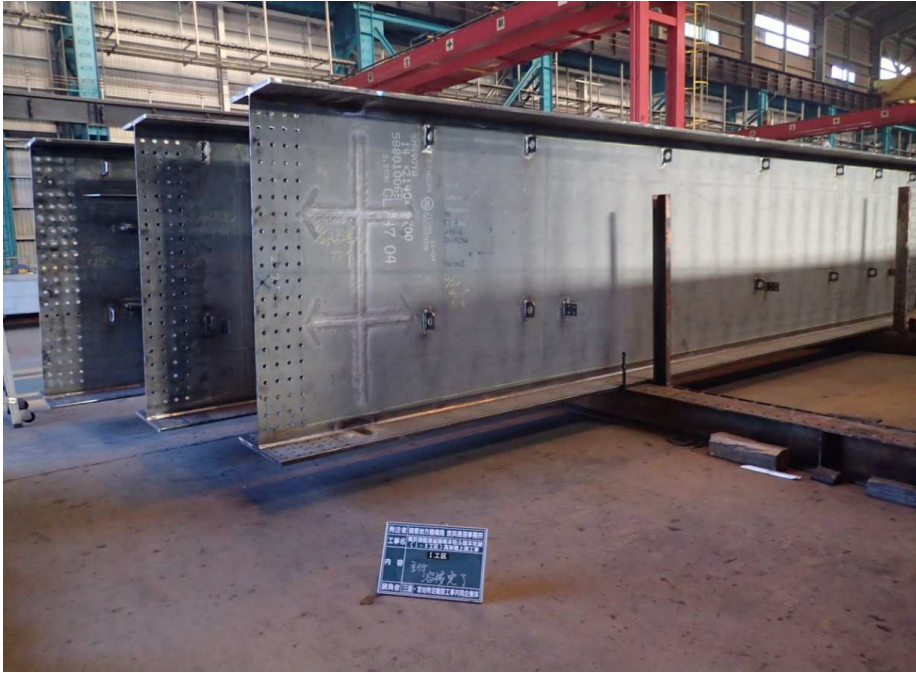
I 工区工場製作状況(S1-J4)
