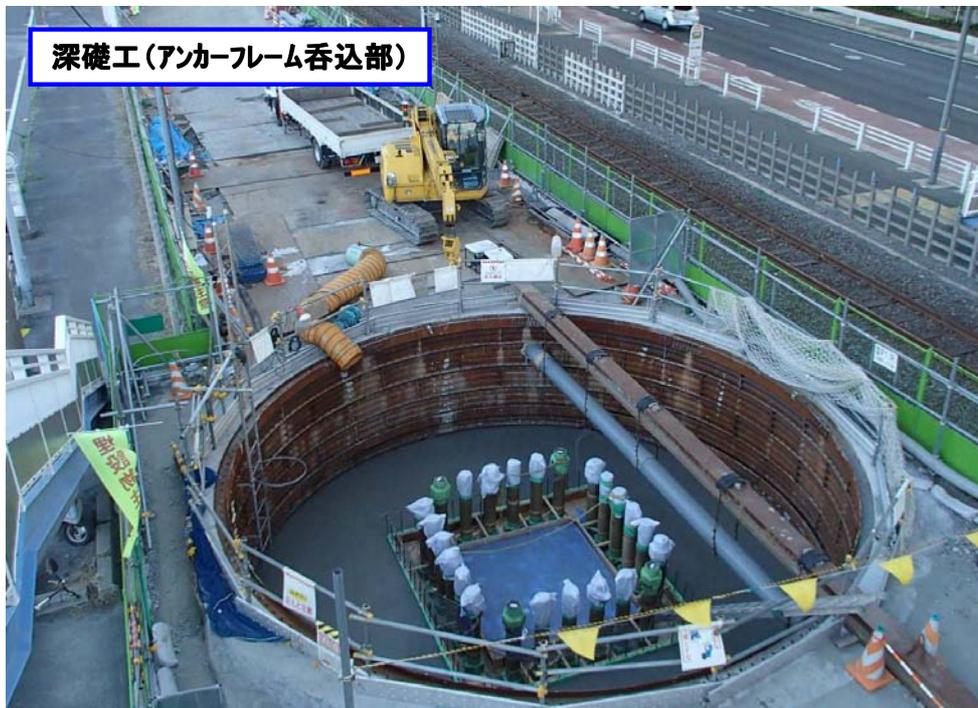
今月は、深礎工(掘削・土留・鉄筋組立・コンクリート打設)と橋脚架設工を行いません。
