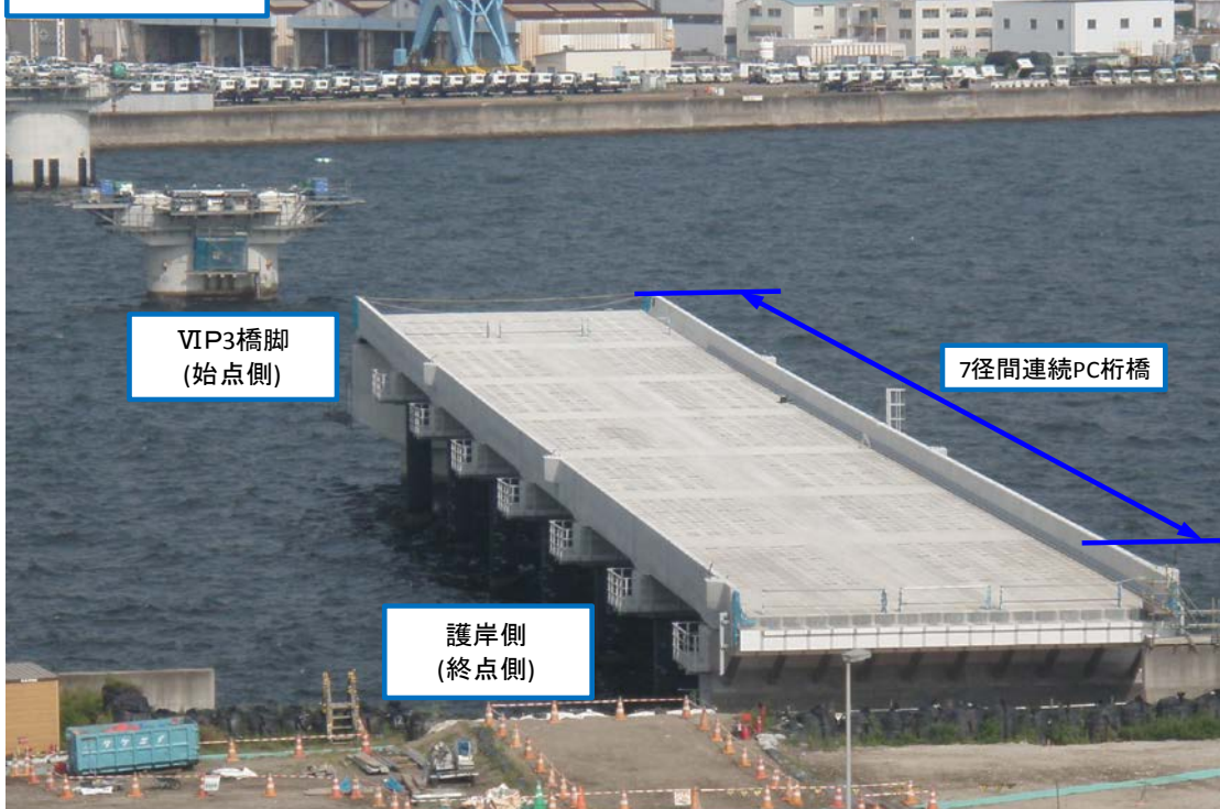
PC橋全景写真(海側) 7径間連続PC桁橋
