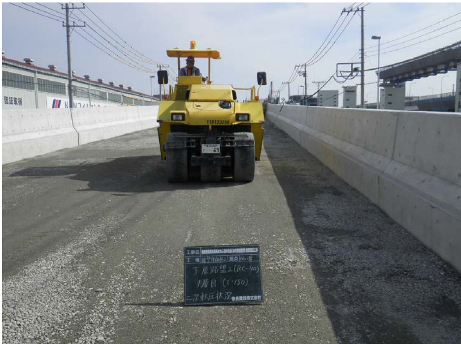
写真① 擁壁部舗装工(路盤転圧状況)
