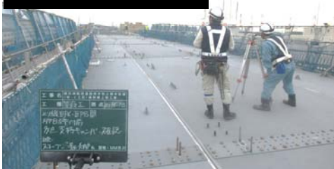
桁位置調整後の測量
