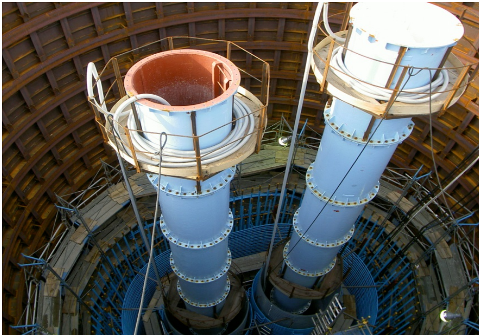
橋脚工 鋼殻内にて初期構築(鉄筋組立状況)
