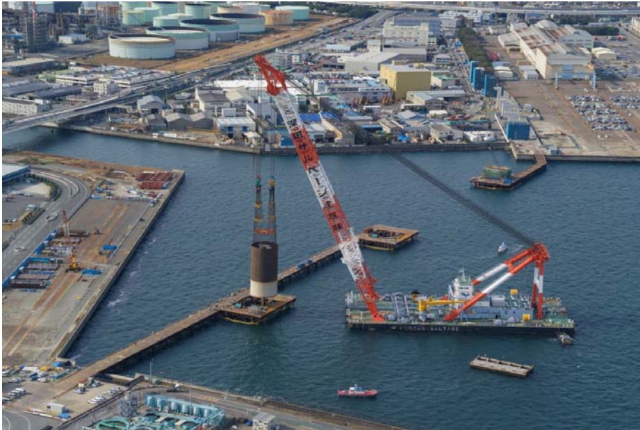
ニューマチックケーソン基礎工 海上クレーン(3000t吊り)によるケーソン基礎の据え付け状況
