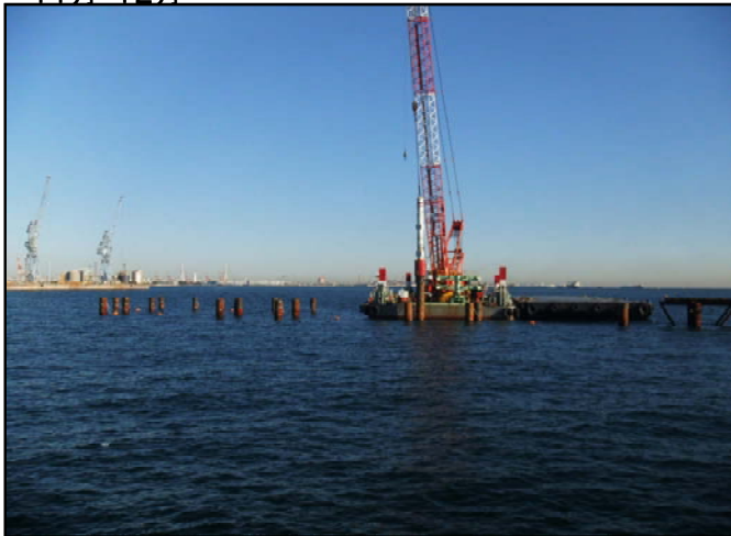
鋼管杭打設状況
