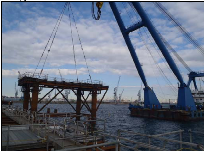
ジャケット据付状況
