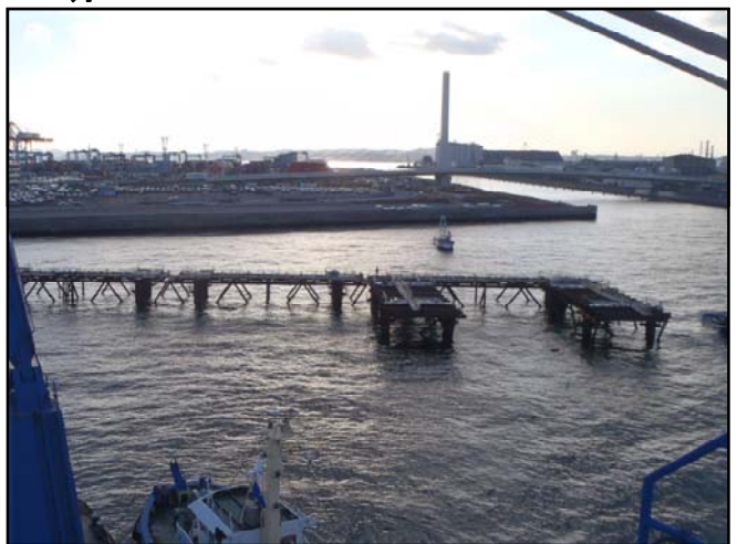
ジャケット据付完了
