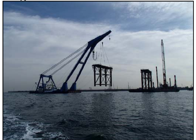
ジャケット据付状況
