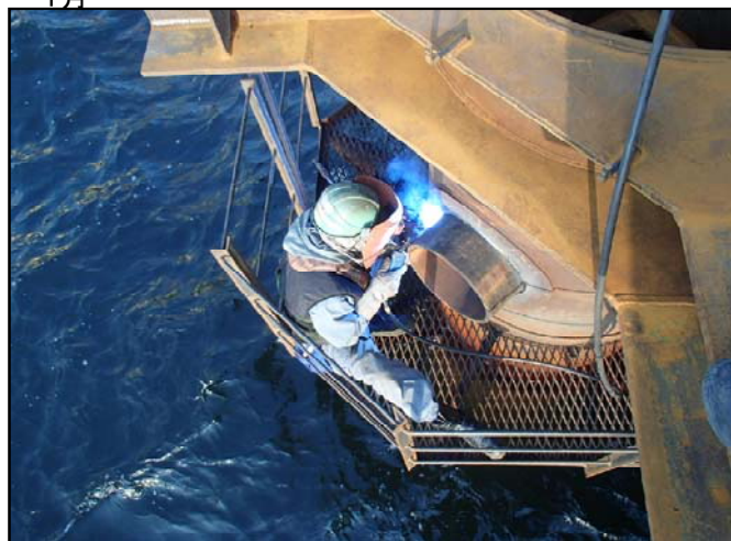
現場溶接状況
