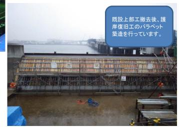
写真② 擁壁工 底版鉄筋組立完了
