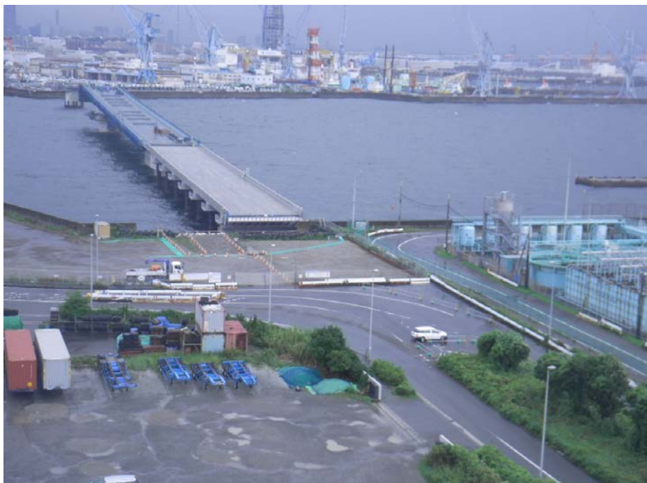
写真① 着工前 現況(全景)
