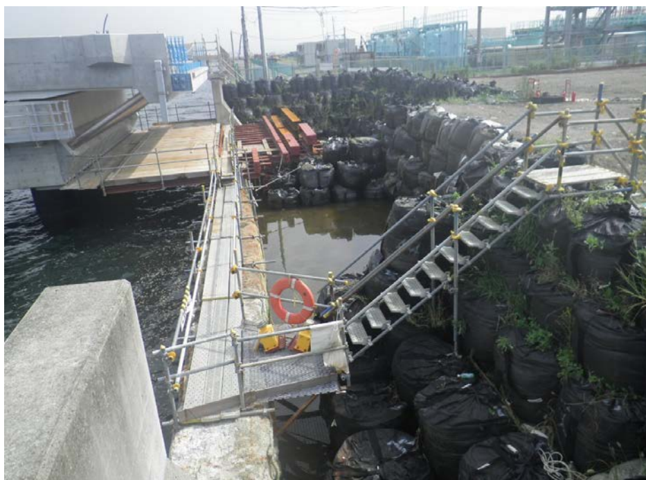
写真② 着工前 現況(仮設工施工箇所)
