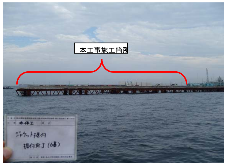
②ジャケット据付完了
