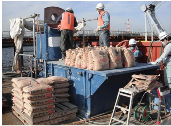
グラウト混練状況
