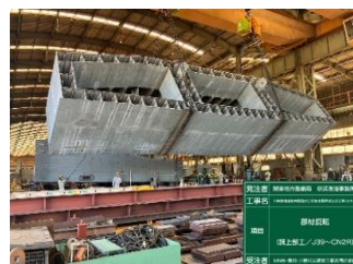
工場製作 接合桁 令和6年9月
