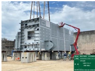
工場製作 MP4主塔中段ブロック 令和6年7月
