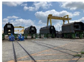
工場製作 MP4主塔上段ブロック 令和6年8月
