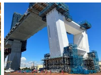
現地工事 MP4全景 令和6年9月
