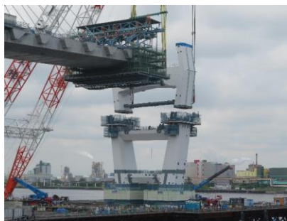
主塔(MP3) 中段ブロック架設作業 作業日: 令和6年6月 (3,000t吊り起重機船、12,500t積台船)
