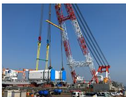
主塔(MP3) 下段ブロック浜出し作業 積込: 令和6年3月 JFE津製作所 (3,000t吊り起重機船、12,500t積台船)
