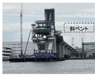
主塔(MP3) 斜ベント取付後状況 作業日: 令和6年9月
