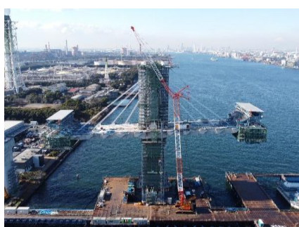
MP2 張出架設 10BL 令和6年2月
