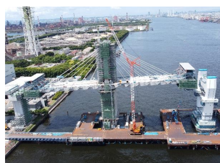
MP2 張出架設 14BL 令和6年6月
