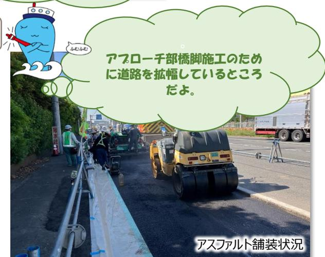
アプローチ部橋脚施工のために道路を拡幅しているところだよ。
