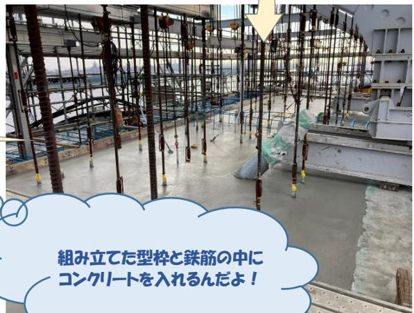
組み立てた型枠と鉄筋の中にコンクリートを入れるんだよ!
