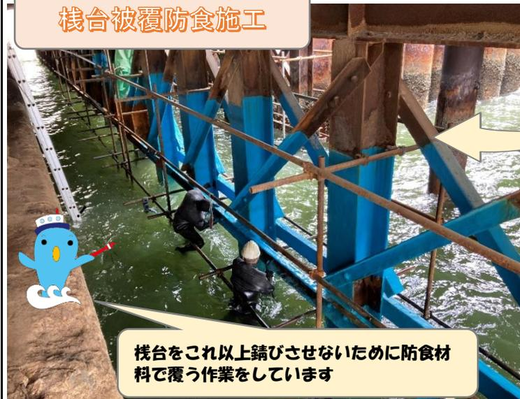
栈台をこれ以上錆びさせないために防食材料で覆う作業をしています
