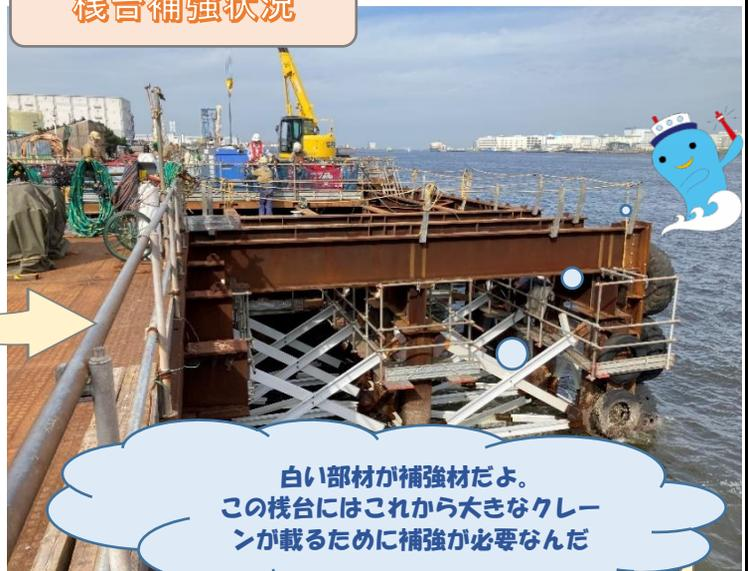
白い部材が補強材だよ。この栈台にはこれから大きなクレーンが載るために補強が必要なんだ
