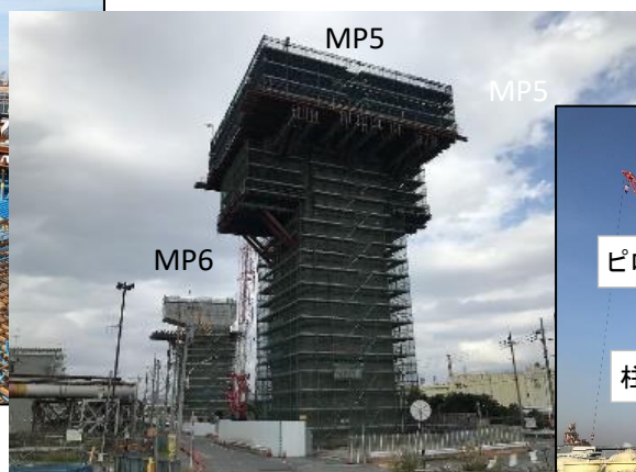
上部工事 MP5・6橋脚状況 令和4年10月
