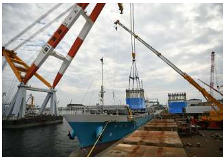
工場製作主塔アンカーフレーム浜出し 令和4年10月（三重県津市） （※1:次ページ図面参照）
