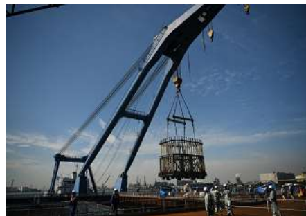
主塔アンカーフレーム現場据付 令和4年10月（400t吊起重機船）
