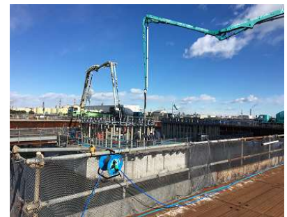
MP3フーチングコンクリート打設 令和5年1月
