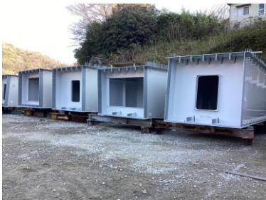
工場製作(OFF工区・日立) 令和4年12月 (主桁)
