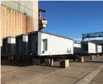
工場製作(4工区・JFE) 令和4年12月 (主桁)
