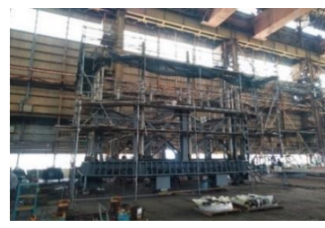
工場製作 MP4アンカーフレーム 令和4年9月
