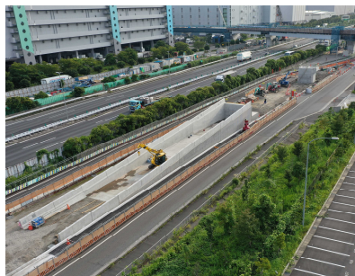
全景(OFF工区) 令和4年10月
