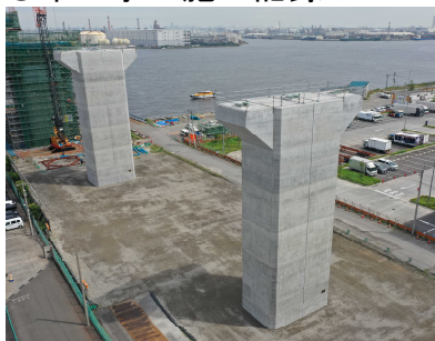
全景(5工区) 令和4年8月
