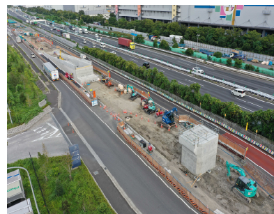
全景(OFF工区) 令和4年10月
