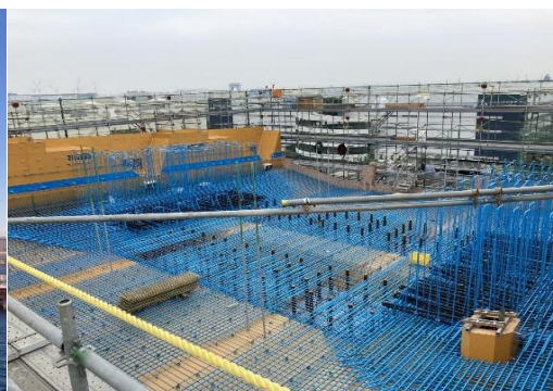
上部工事 MP2PC箱桁工 令和4年6月
