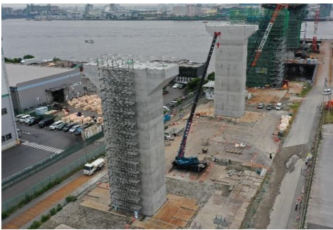
全景(5工区) 令和4年6月
