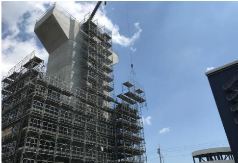
足場支保工解体 令和4年6月
