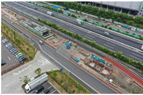
全景(OFF工区) 令和4年6月
