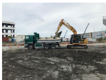
準備工(4工区) (建設発生土積込) 令和4年4月
