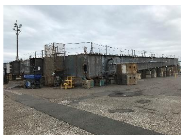
工場製作(4工区) (仮組立状況) 令和2年8月～令和4年3月
