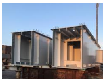
工場製作(4工区) (工場塗装完了) 令和4年5月
