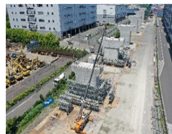
昇降設備工(4工区) (設置作業状況) 令和4年5月
