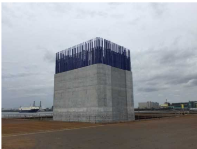
上部工事 MP2橋脚状況 令和3年7月
