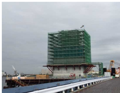
上部工事 MP2脚頭部工 令和3年8月
