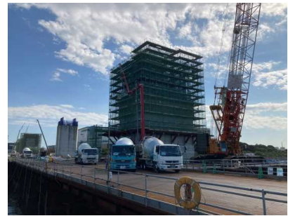
上部工事 MP2脚頭部工 令和3年9月
