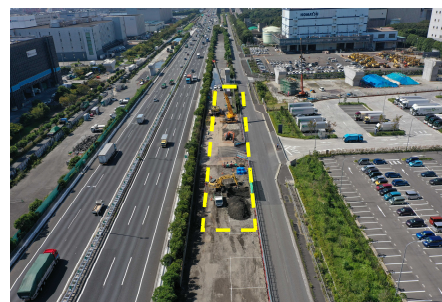
全景(OFF工区) 令和3年10月
