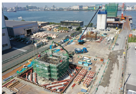
全景(5工区) 令和3年10月
