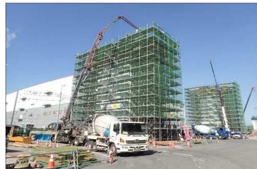
【写真④】梁コンクリート打設
