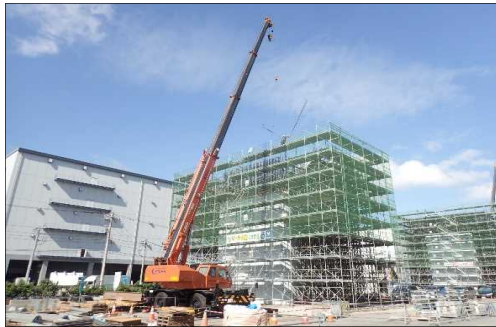
【写真①】クレーンによる材料吊込み
