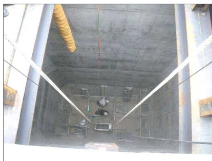
中空内部足場解体(SP16) 令和3年8月
