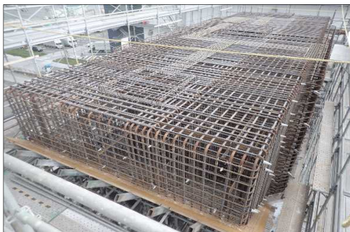
【写真③】橋脚梁部鉄筋
