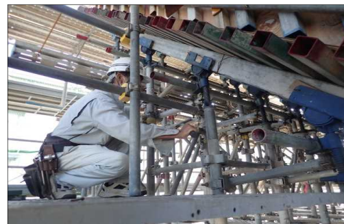
【写真⑥】打設時支保工点検
