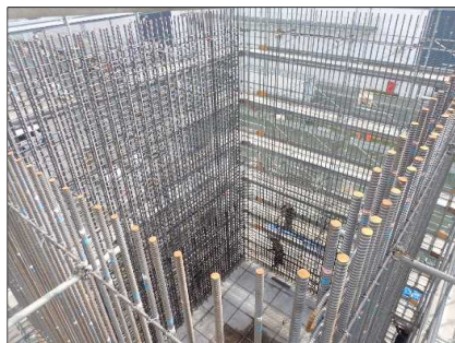
柱鉄筋組立(SP15) 令和3年7月
