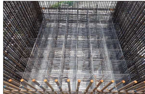
【写真②】橋脚柱部鉄筋
