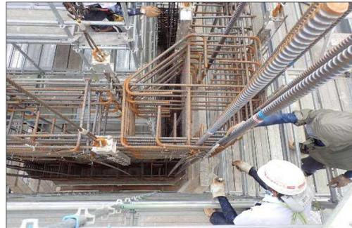
【写真②】橋脚中空部鉄筋建込み
