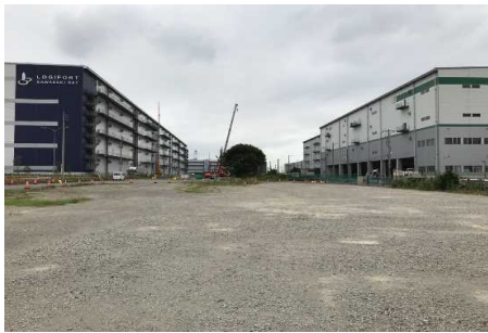
着工前 令和2年9月
