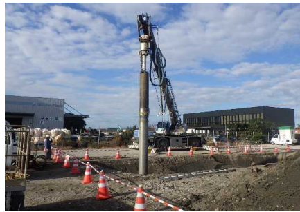
支障物撤去(松杭) 令和2年12月
