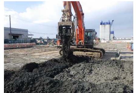
仮設工(地盤改良) 令和3年2月
