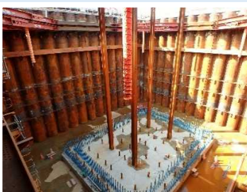
・支保工計画を見直し、橋脚2ロット構築後、井筒内に大きな空間を確保。
