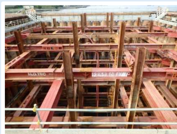
・橋脚1～2ロットのコンクリート打設まで設置していた支保工。
