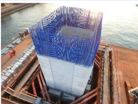
・高さ35.1mのMP2。全体を8ロットに分け、段階的に施工しました。（左：上空から／右：井筒内から）
