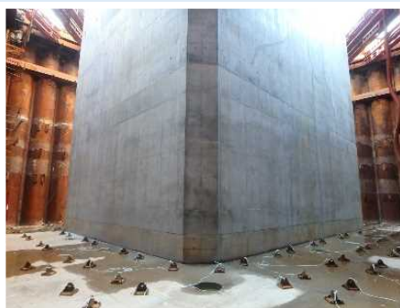
・高さ35.1mのMP2。全体を8ロットに分け、段階的に施工しました。（左：上空から／右：井筒内から）
