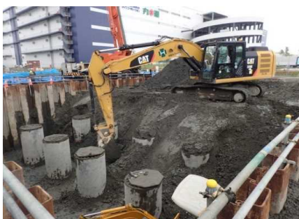
床堀状況 令和2年9月
