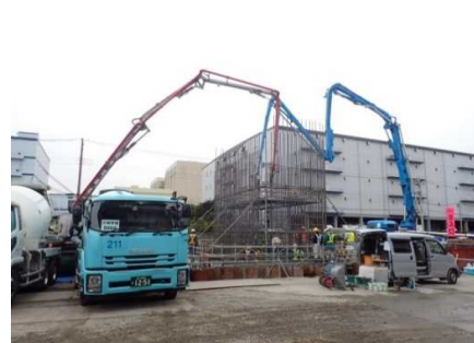
フーチングコンクリート打設 令和2年11月
