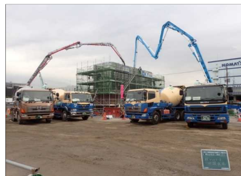
写真⑤柱コンクリート打ち込み
