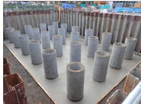
写真②均しコンクリート打設
