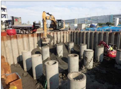
写真①基礎厚さまでの掘り下げ
