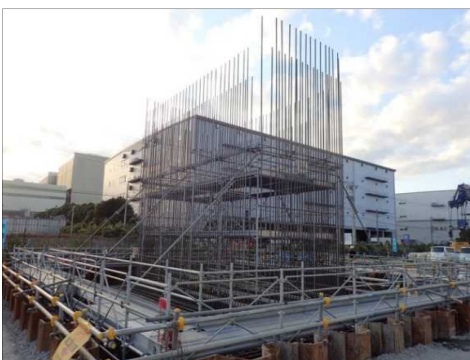
写真④柱部の鉄筋
