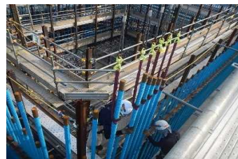
鉄筋組立 (5ロット目) 令和2年7月
