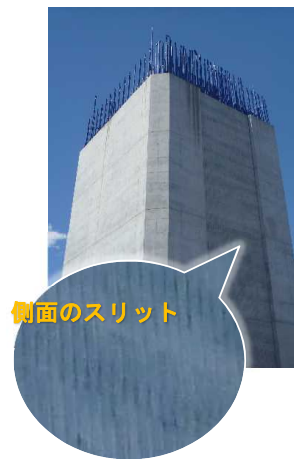
(参考) 【MP 1 橋脚側面】
