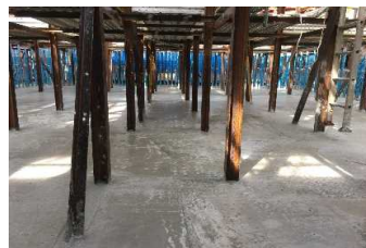
コンクリート打設完了 (4ロット目) 令和2年7月
