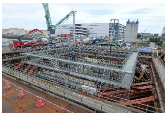
コンクリート打設 (4ロット目) 令和2年7月
