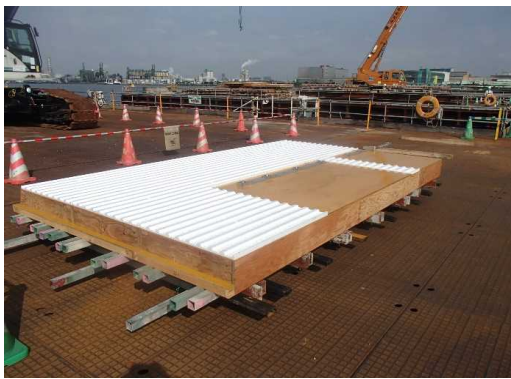
【型枠組立作業】
