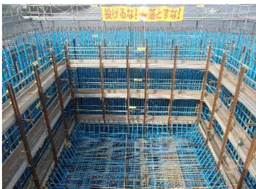
【鉄筋組立完了】
