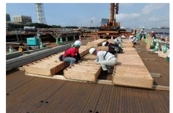
型枠組立 (5ロット目) 令和2年8月
