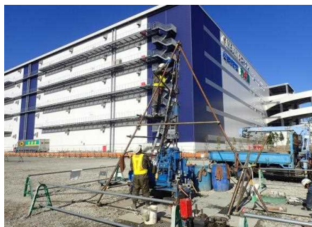
地盤調査 令和2年 2月
