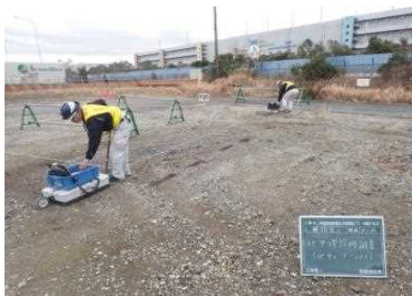
地中管調査 令和2年 2月
