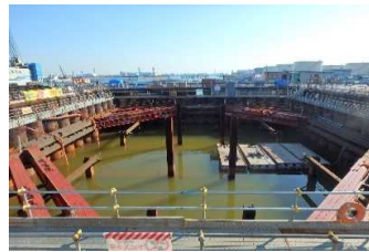
盛替え支保工設置 令和2年3月
