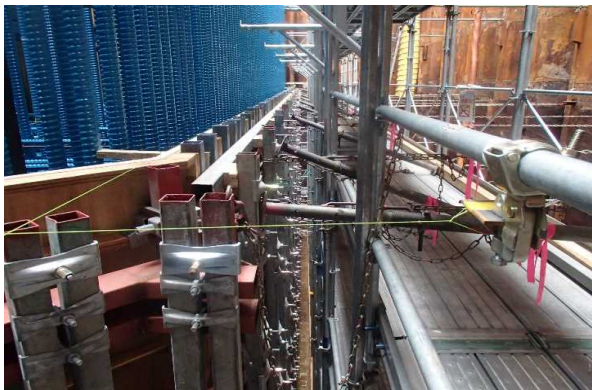
【型枠組立完了】
