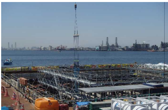
【型枠組立完了】
