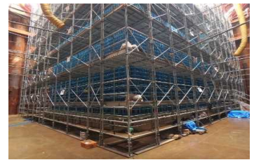
鉄筋組立 令和2年5月
