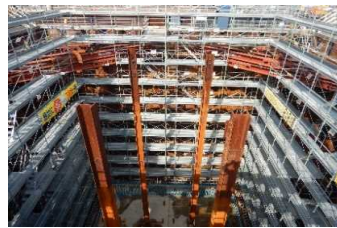
足場組立 令和2年5月
