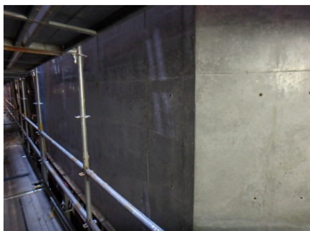
【井筒外側の様子】
