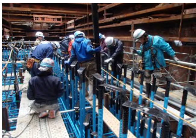
【井筒内部の作業】
